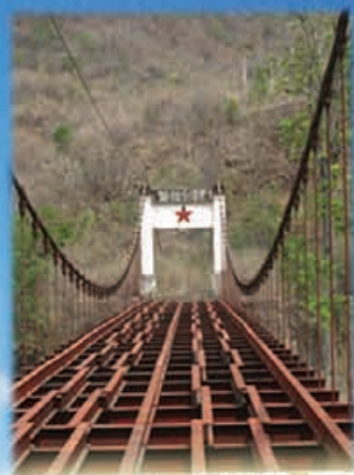
「一分鐘改寫歷史」的惠通橋，橋板雖已被拆除，但絲毫不減當年氣勢。
